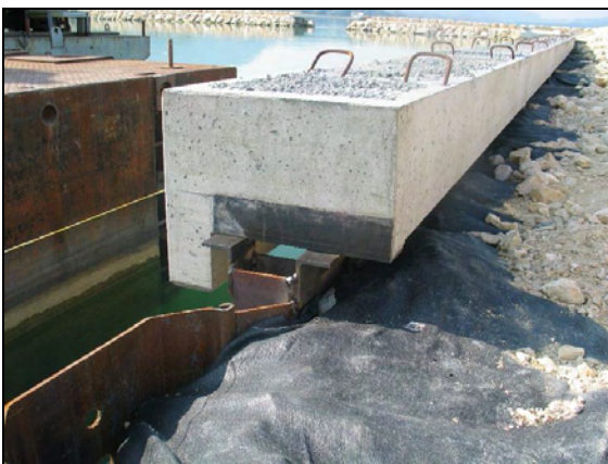
Août 2005, les éléments préfabriqués en atelier s'ajustent parfaitement à ce qui est déjà construit...
