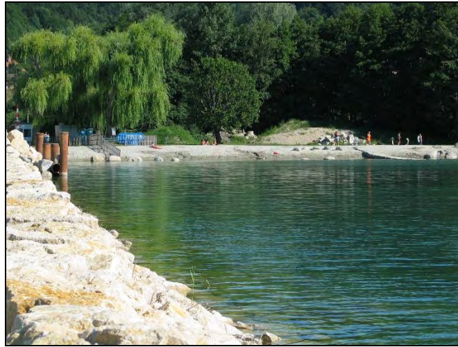
Juillet 2005, réalisation de la plage telle que nous la connaissons aujourd'hui
